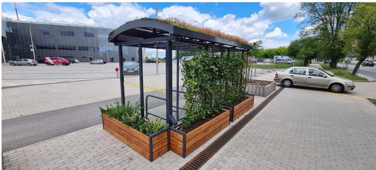
Fot.20. Zastosowanie „zielonego dachu” z wykorzystaniem przystanku autobusowego przy ul. Struga (materiały własne UM)
