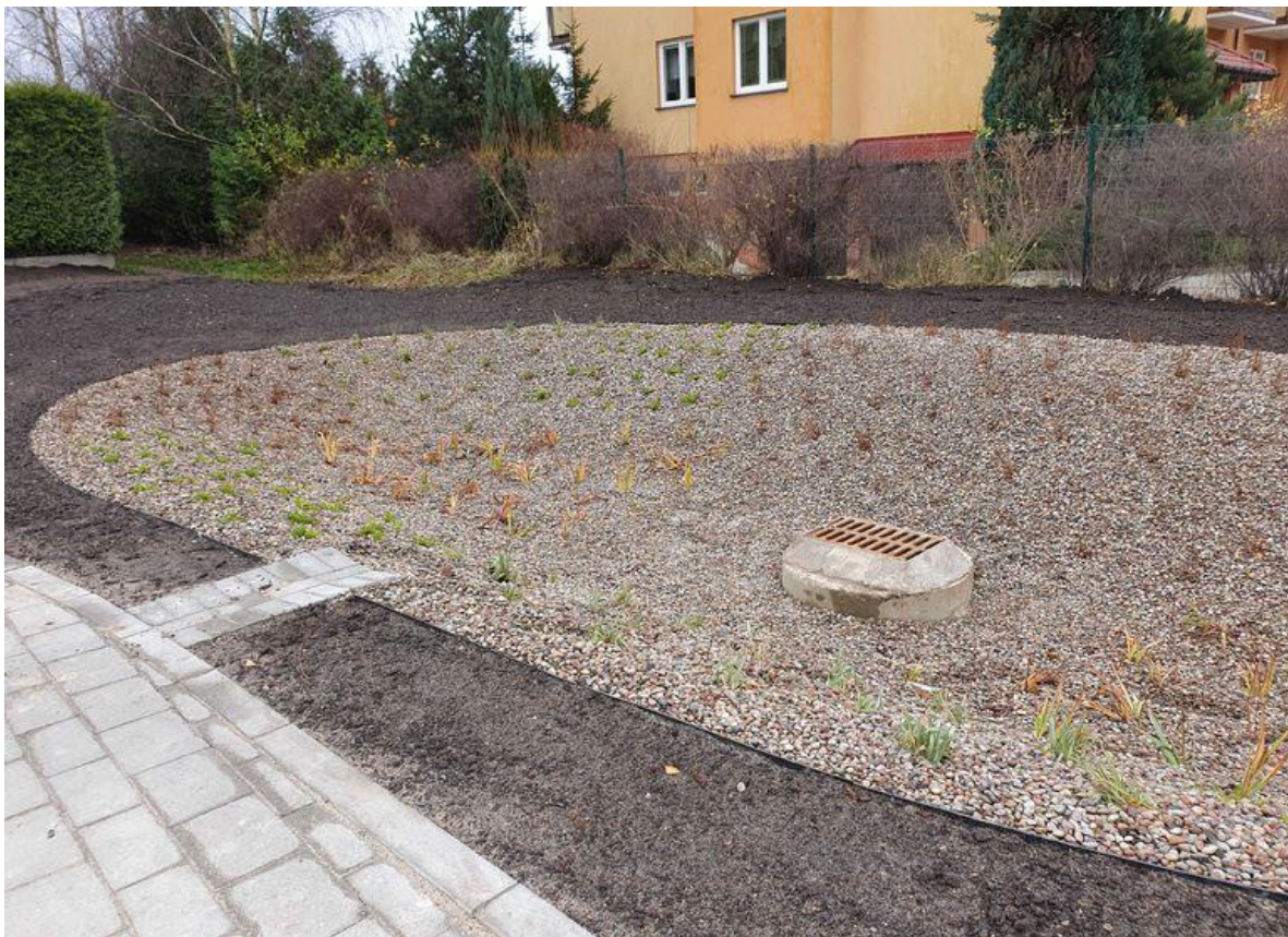
Fot. 15. Gdańsk - Ogród deszczowy Flory (Powierzchnia: 61,21 m 2 ; Pojemność: 24,3 m 3 )
