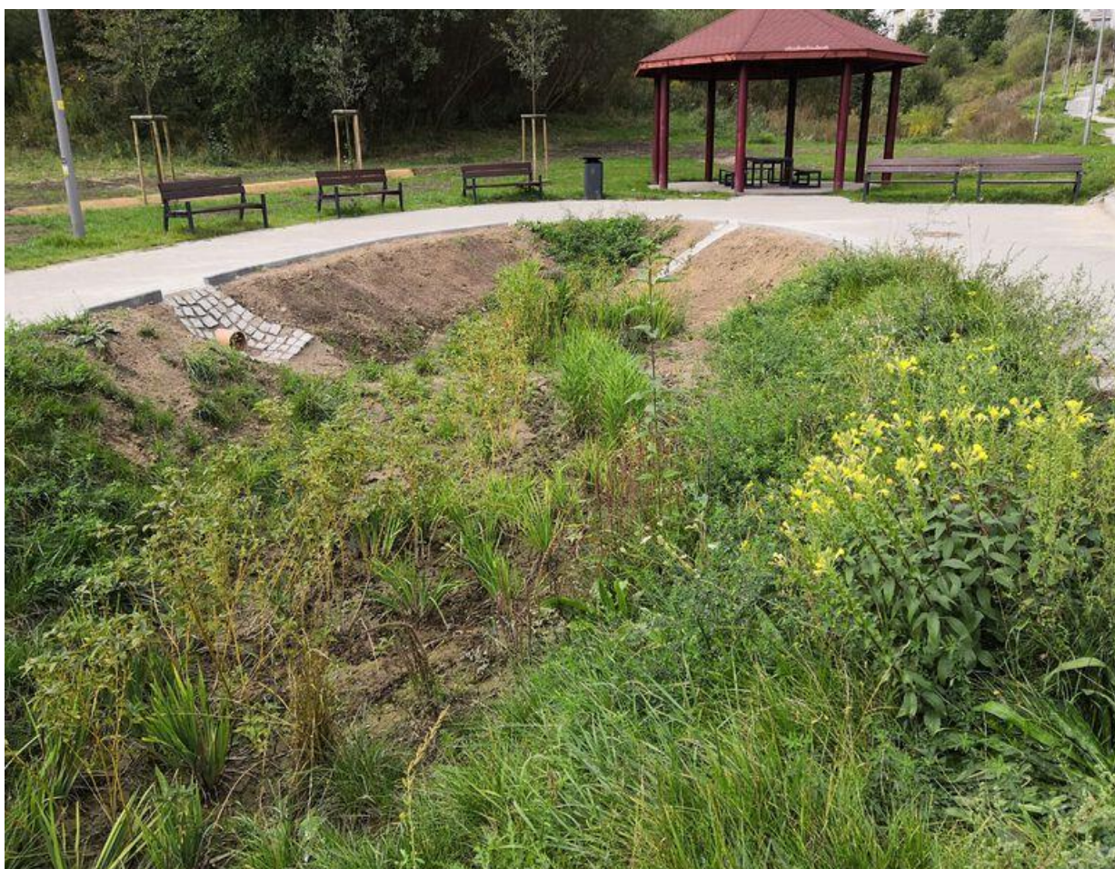
Fot. 16. Gdańsk - Ogród deszczowy Jar Wilanowska (Powierzchnia: 83,41 m 2 ; Pojemność: 39,15 m 3 ).
