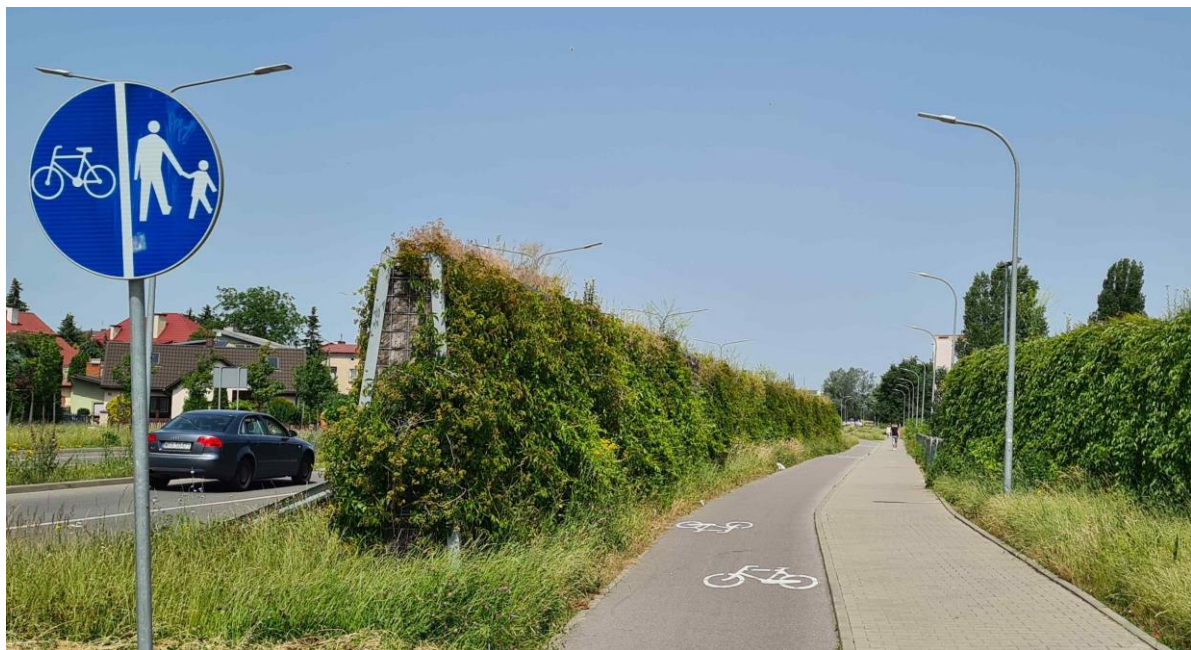
Fot. 42. Ciąg pieszo - rowerowy przy ul. Pallotyńskiej z zastosowaniem zieleni izolacyjnej (pnączy) - materiały własne UM
